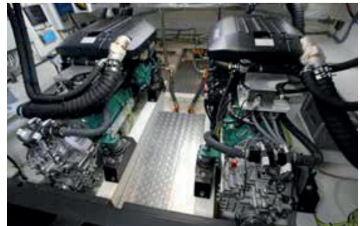
14 kW elmotorer från tyska Mahle är monterade mellan Pentadieselmotorerna och växellådorna.
