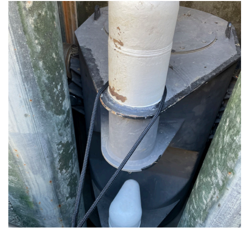
I de stora slussarna fäste man båten på mitten vid en flytpollare, som flöt upp i en ränna i väggen tillsammans med båten.
